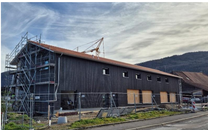
Image : Bâtiment de Poste Area en phase finale de construction avec les bureaux en propriété d'AgriJura à l'étage, vu depuis la route principale du village de Glovelier
